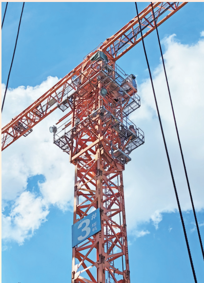
台风“巴威”刚过境，烈日酷暑便接踵而至。正鑫公司接到一项紧急任务：拆卸梅花洲科创中心项目3#
